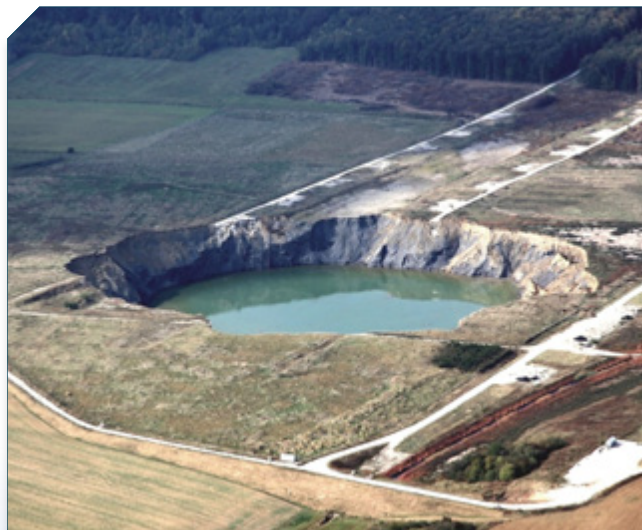
Vue de l'effondrement dirigé de la cavité d'exploitation saline de Cerville-Buissoncourt (société Solvay) étudié par le GISOS.
