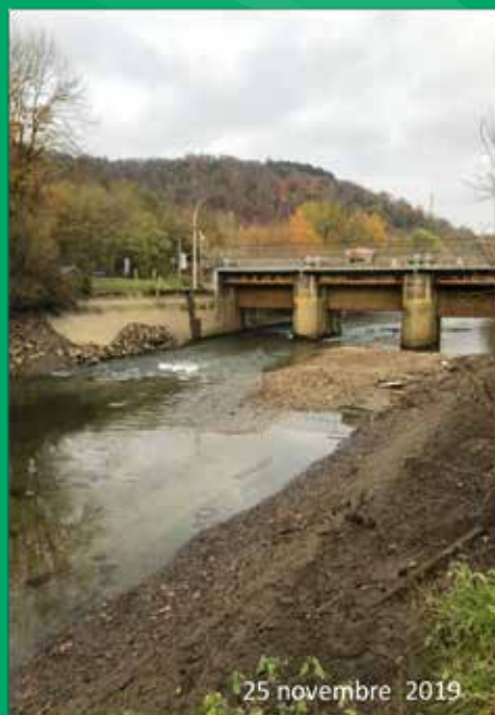
Figure 3 : Le barrage de BETH à Moyeuvre-Grande en fonctionnement le 13 août 2013, lors de la crue biennale du 5 juin 2016, ouvert le 25 novembre 2019 avec les premiers signes de déstabilisation des sédiments contaminés en rive droite du barrage le 10 janvier 2020.
